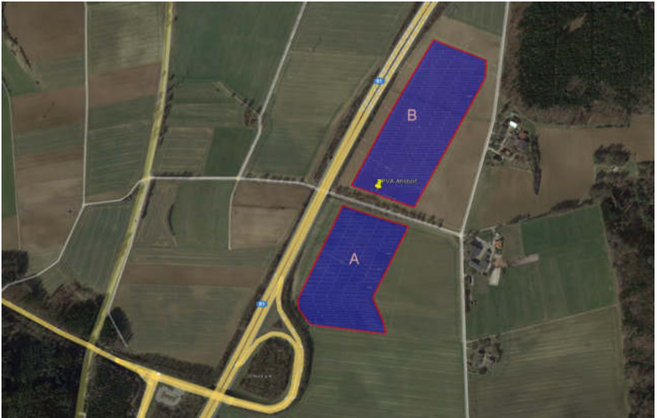
Bild 2.1.2: Detailansicht der PV Flächen (Quelle: Google Earth/SolPEG)
